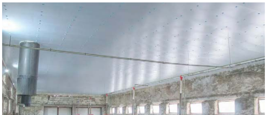
Fot. 7. Płyty termoizolacyjne zamontowane wewnątrz chlewni ( www.olx.pl )
