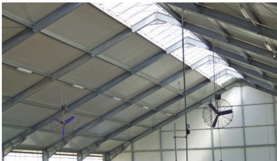
Fot. 1. Wentylatory i regulowana kalenica – dobre sterowanie mikroklimatem (źródło: R.J. Szulc)
