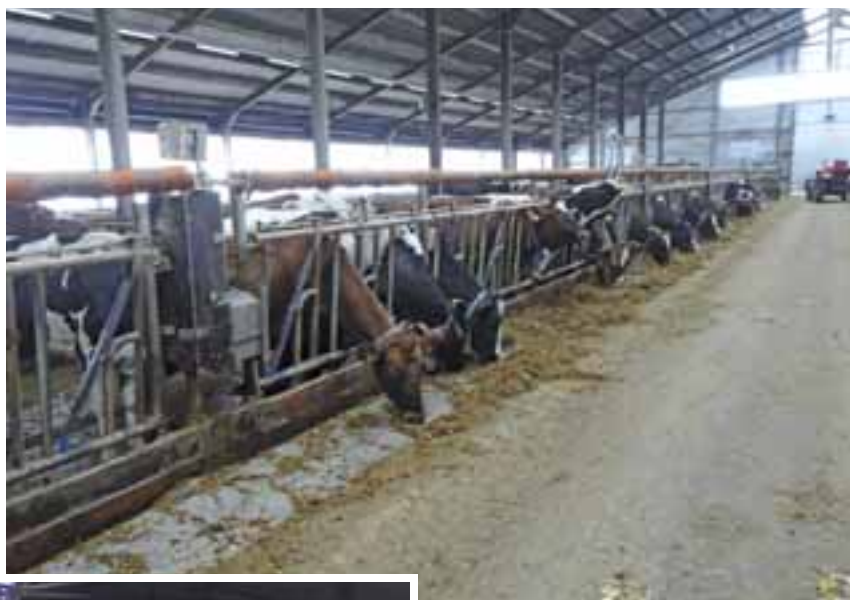
Fot. 3. Pokrycie części stołu paszowego specjalną farbą ułatwia zachowanie trwałości i higieny powierzchni
