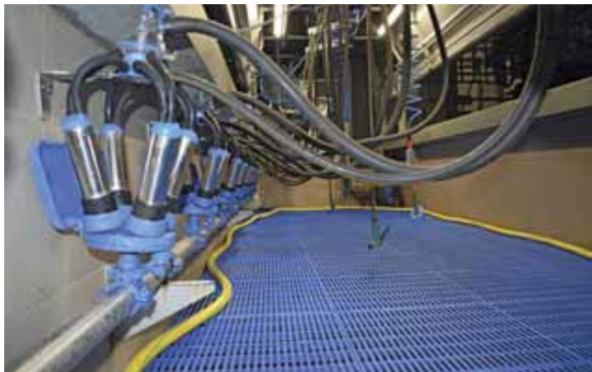
Fot. 8. Posadzka dla dojarza zapewnia czystość i wygodę doju, kratka delikatnie ugina się pod ciężarem, co jest dobre dla zdrowia kręgosłupa osoby obsługującej halę
