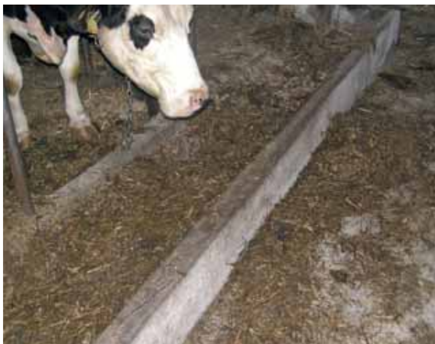
Fot. 1. Betonowy żłób paszowy to często występujący element stołu paszowego, szczególnie w starszych oborach
