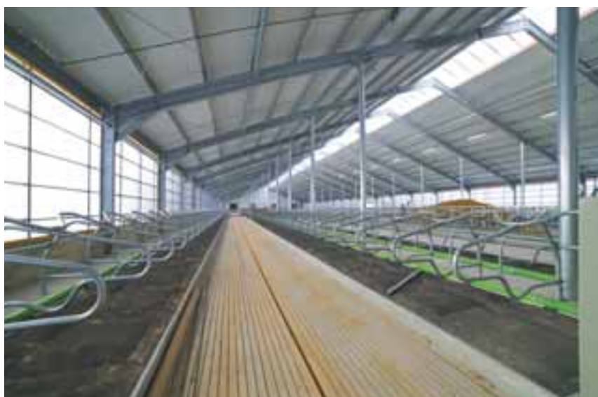
fot. archiwum prywatne Szczuka Budownictwo
