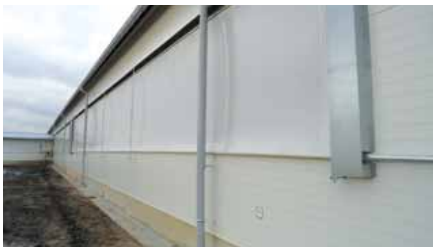
Fot. 6. W oborze zwłaszcza typu „zimnego” ściany boczne powinny mieć możliwości techniczne dostarczenia odpowiedniej ilości świeżego powietrza do wnętrza, jeżeli zajdzie taka potrzeba
