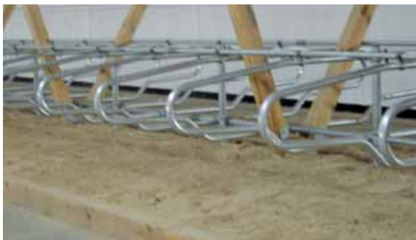
Fot. 1. Boksy legowiskowe wypełnione piaskiem, to coraz częściej spotykane rozwiązania w nowoczesnych obiektach, które mogą zapewnić należyty komfort bytowania zwierząt
