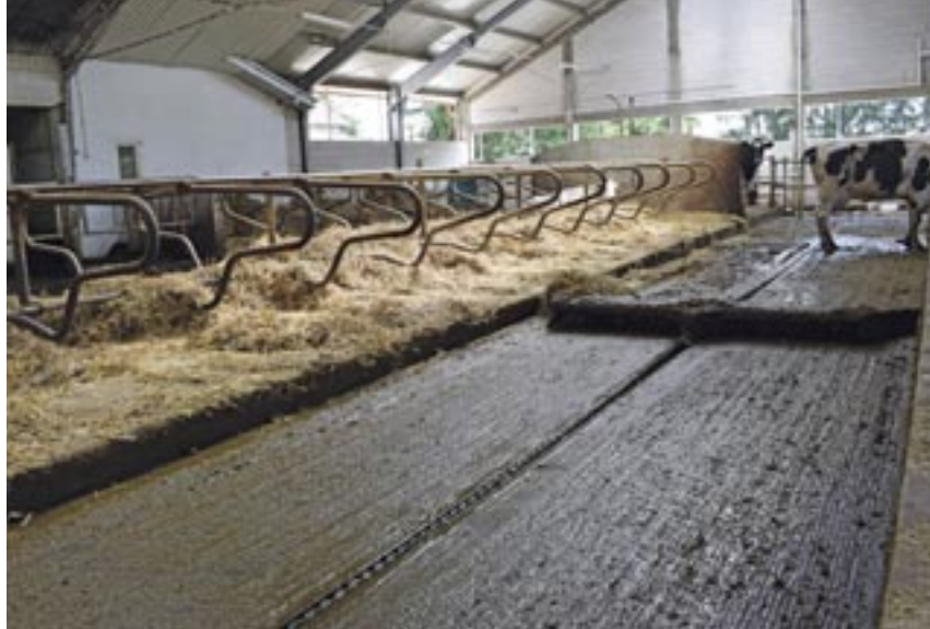
Fot. 4. Podczas modernizacji obiektu uzupełniono wyposażenie; zamontowano m.in. 3 wentylatory śmigłowe, poidła, czochradła, system zgarniaczy obornika
