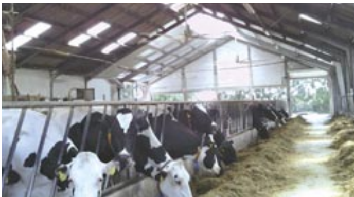
Fot. 7a. Widok na dach starej części obory pokrytej EuroFalą i nowej części pokrytej płytą warstwową
