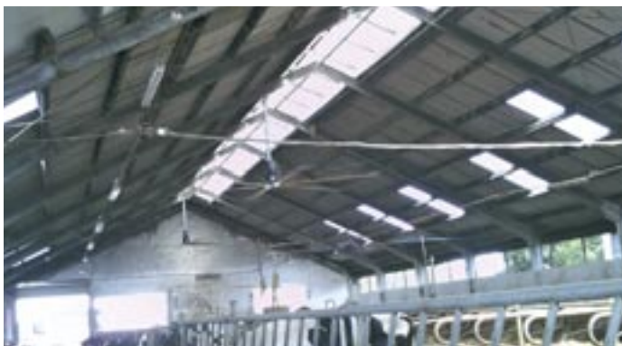
Fot. 8a. Stara część obory ze starym pokryciem dachu, czyli z EuroFalą
