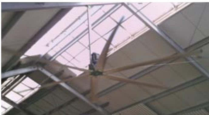
Fot. 9a. Nowa część obory, dach pokryty płytą wielowarstwową, zamontowany mieszacz powietrza o 5 metrowym zasięgu śmigieł
