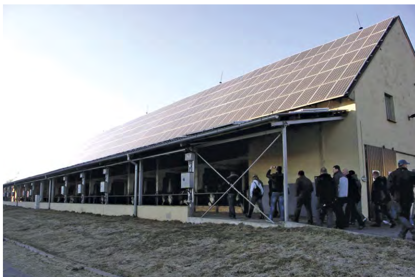
Fot. 3. Dach jałownika wydzierżawiony przez właściciela firmie fotowoltaicznej
