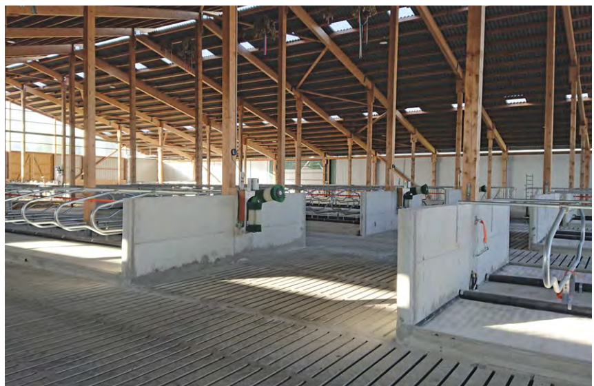
Fot. 6. Nowoczesna obora (w budowie) przed zasiedleniem z elastyczną podłogą legowiska, wyposażona w roboty udojowe (okolice Kilonii w północnych Niemczech)
