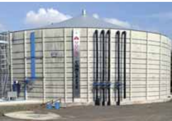
Fot. 2. Żelbetowy zbiornik do przechowywania gnojowicy (fot. www.moore-concrete.com )
