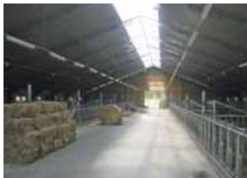
Fot. 1a. Właściwie zaplanowany i naturalnie doświetlony korytarz paszowy
