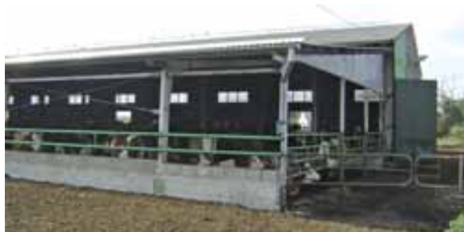
Fot. 6. W pełni otwarte ściany budynku obory to coraz częściej spotykane rozwiązanie technologiczne w krajowych w obiektach dla bydła mięsnego
