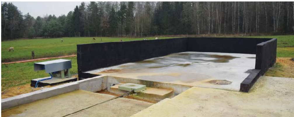
Fot. 8. Zbiornik ma wymiary 6 x 10 i 2,5 metra głębokości, czyli przewidziany jest na około 120-130 tys. litrów na górze jest miejsce na obornik
