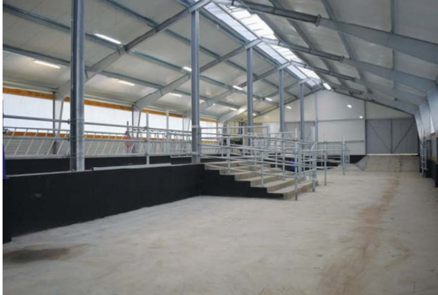
Fot. 4. Obora ma dwa poziomy, w górnej części znajduje się korytarz paszowy, w dole część legowiskowa
