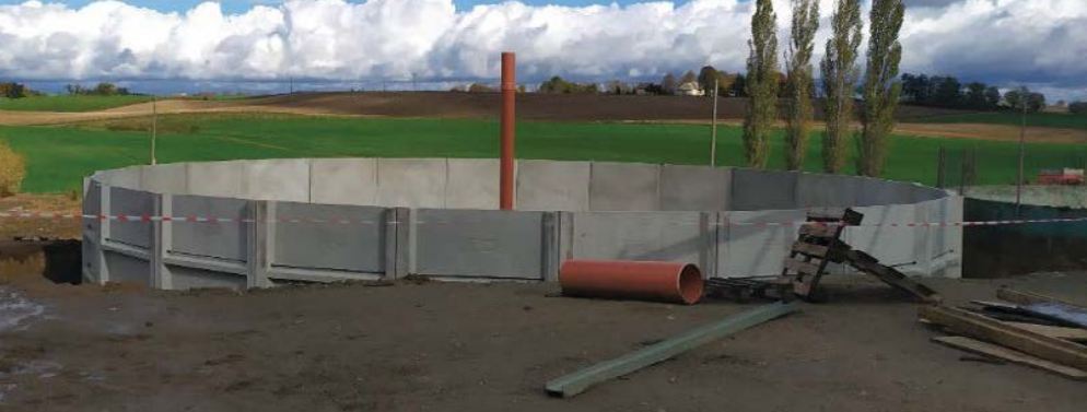
Fot. 2. Prefabrykowany zbiornik na gnojowicę (fot. W. Seroka)
