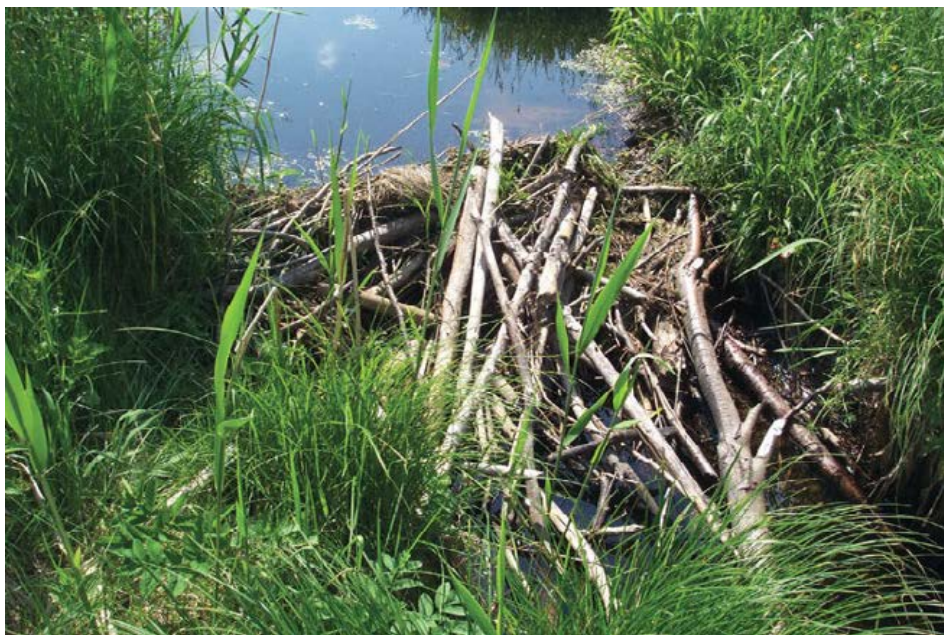
Fot. 5. Utworzona przez bobry tama zatrzymuje odpływ wody w rowie melioracyjnym
