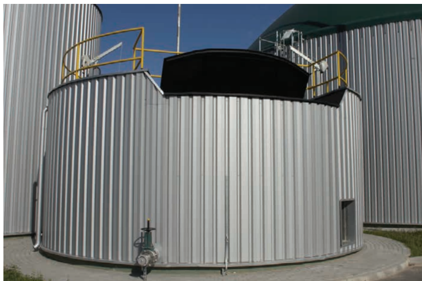
Fot. 4. Naziemny zbiornik wstępny dla substratów w wykonaniu firmy Biowatt (źródło: Biowatt S.A.)
