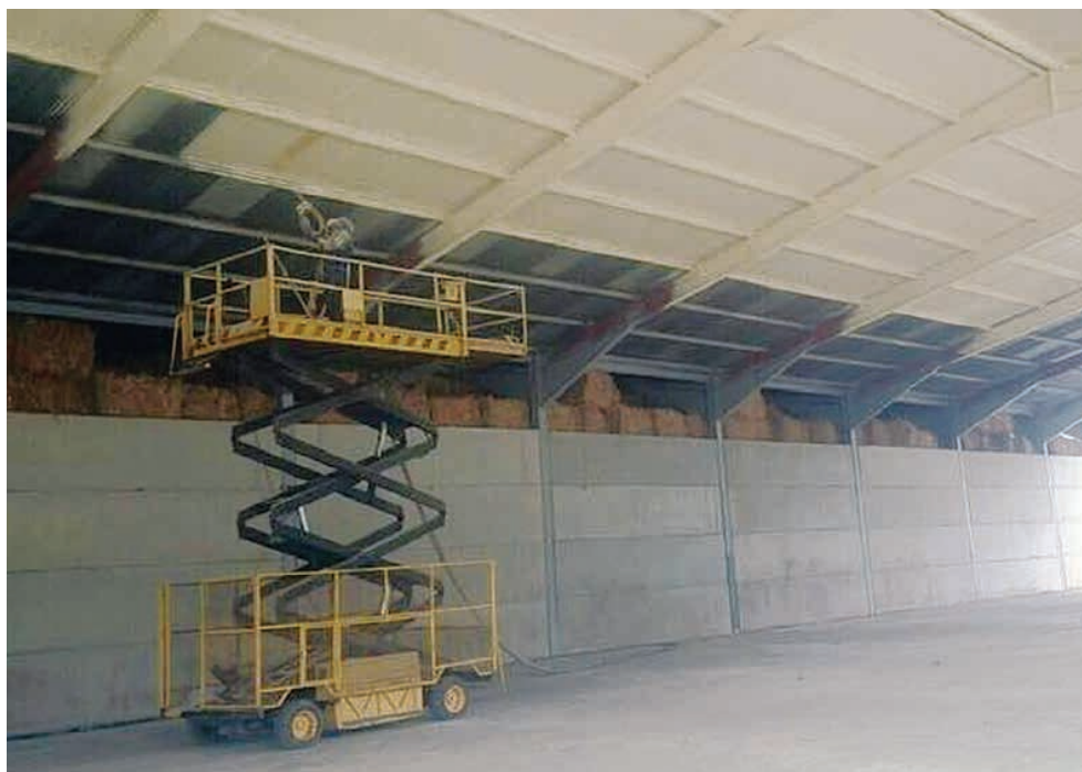
Rys. 2. Nanoszenie pianki PUR metodą natryskową (fot. www.myfoam.ie )
