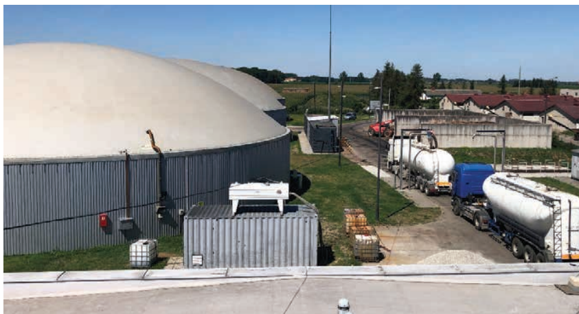
Fot. 1. Zbiorniki z membranowym przykryciem stanowiącym magazyn biogazu, w tle współpracująca z Biogazownią ferma trzody chlewnej (źródło: Biowatt S.A.)
