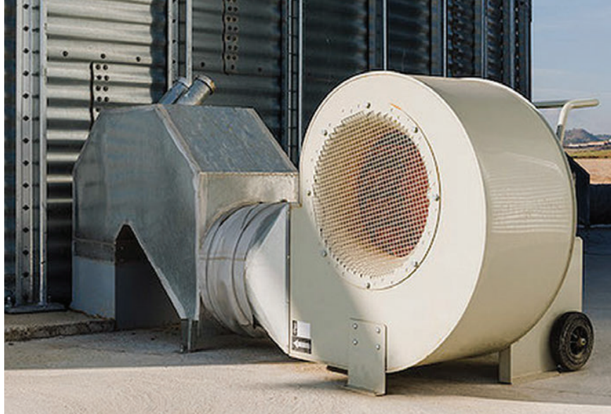
Rys. 4. Wentylator wciągający powietrze do silosu (fot. eltrum.com)
