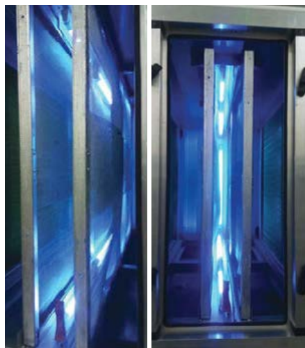
Rys. 5. Bramki fotokatalityczne zamontowane wewnątrz centrali wentylacyjnej w zakładzie wylęgu drobiu na nawiewie
